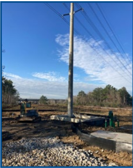
C2 Prepping site
